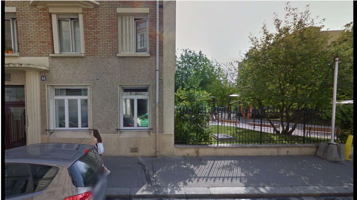
Rue du Dessous des Berges, Paris
